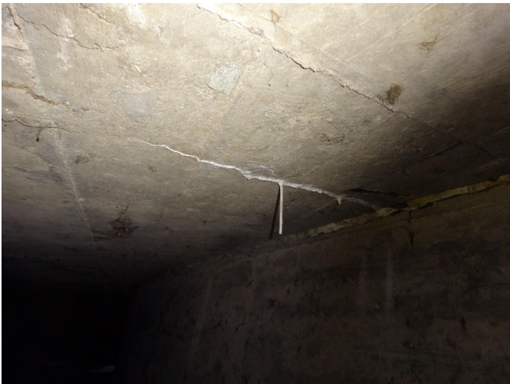
Abbildung 23: Rissbildung mit Durchfeuchtung und Stalaktiten-Bildung
