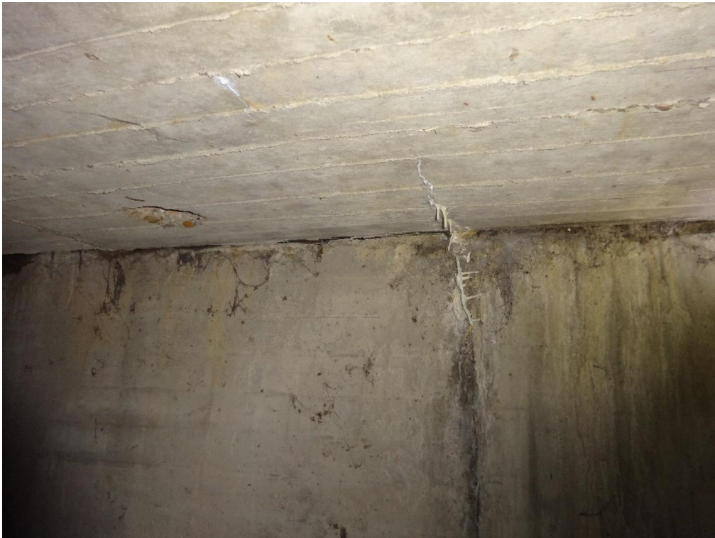
Abbildung 22: Rissbildung mit Durchfeuchtung und Stalaktiten-Bildung
