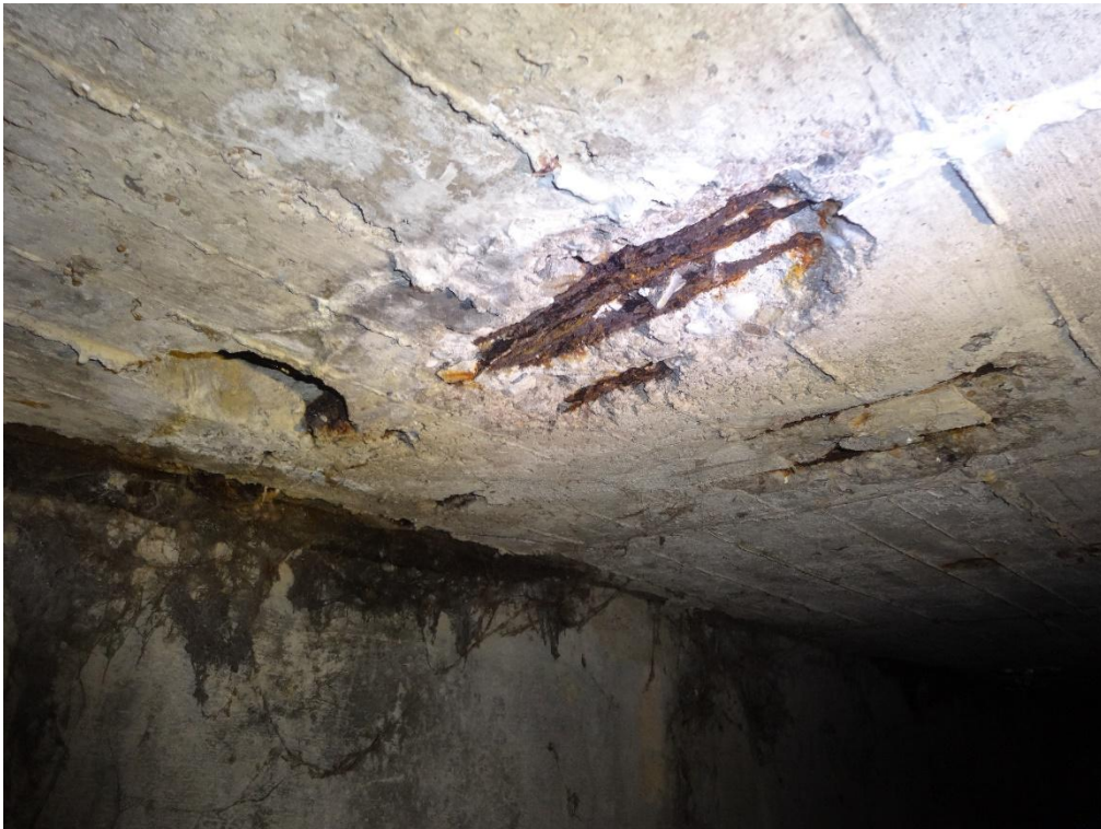
Abbildung 18: Betonabplatzungen und freiliegende Bewehrung von unten
