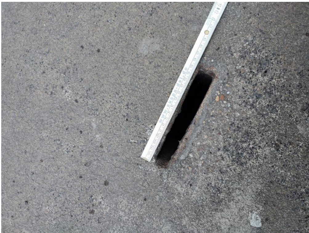
Abbildung 26: Öffnungsschlitz in Stahlbetondeckel
