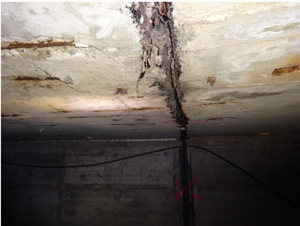
Abbildung 15: Fugenausbildung, zerstörte Fugen
