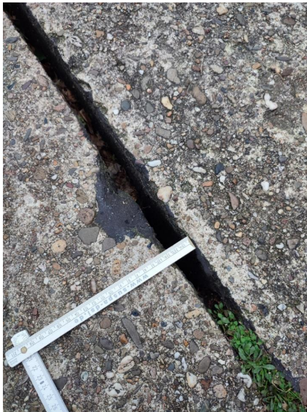
Abbildung 17: Fugenausbildung, zerstörte Fugen von oben
