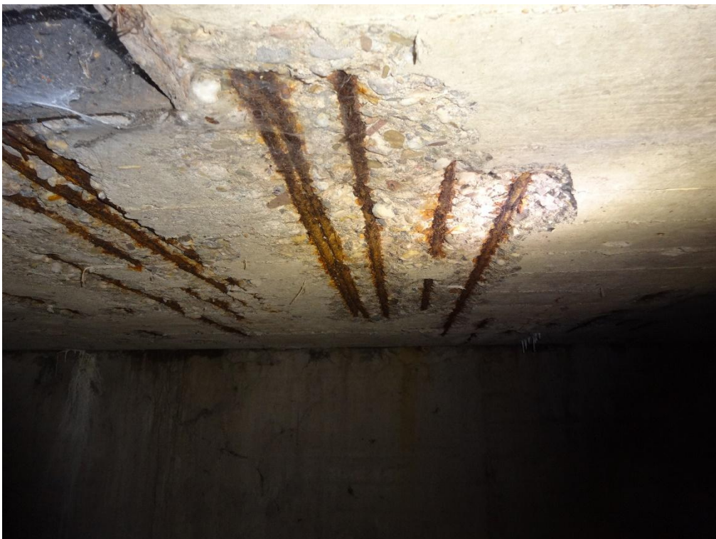
Abbildung 19: Betonabplatzungen und freiliegende Bewehrung von unten
