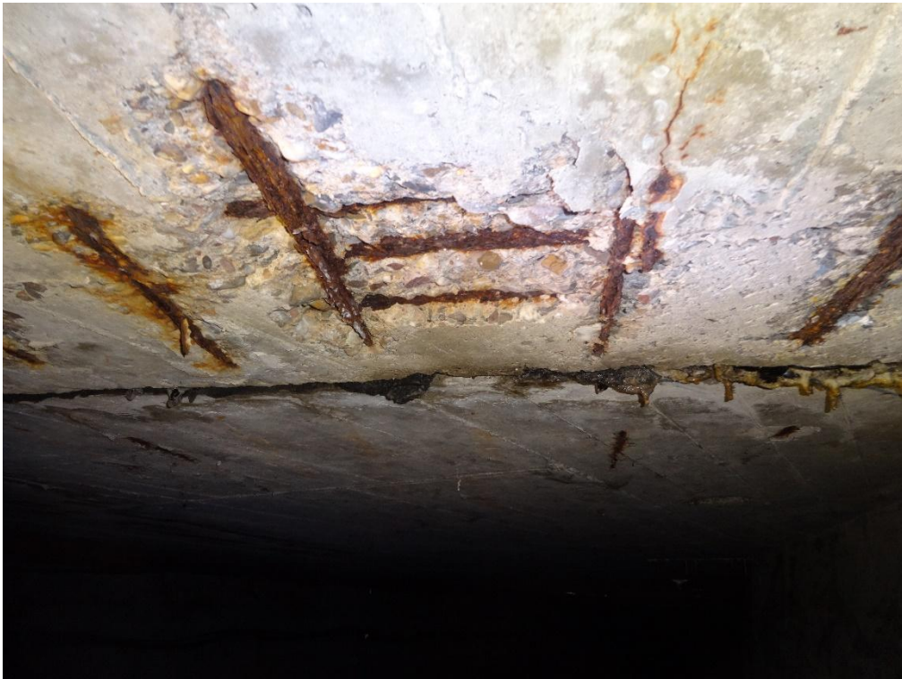
Abbildung 20: Betonabplatzungen und freiliegende Bewehrung von unten
