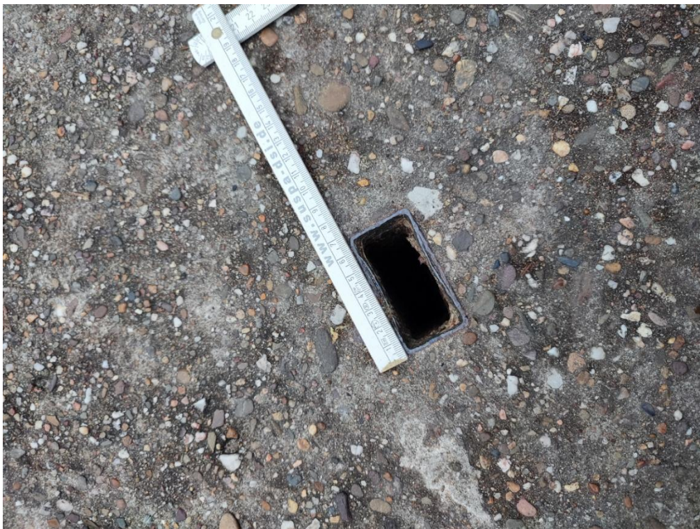
Abbildung 25: Öffnungsschlitz in Stahlbetondeckel
