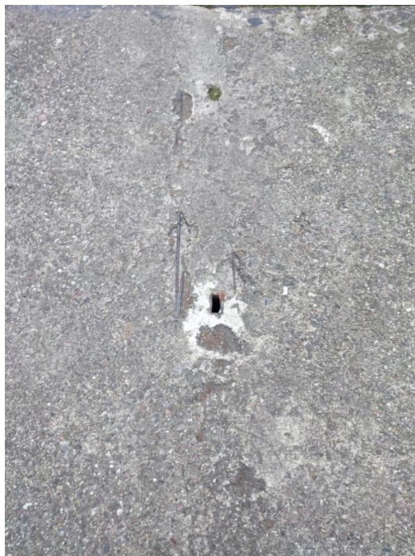
Abbildung 21: Betonabplatzungen und freiliegende Bewehrung von oben
