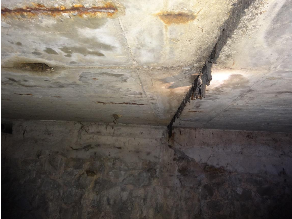
Abbildung 16: Fugenausbildung, zerstörte Fugen
